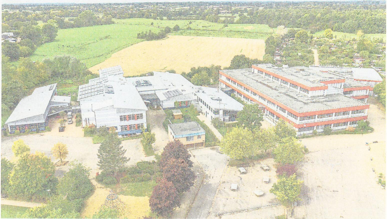
Am Gymnasium Kronshagen (rechts im Bild) läuft es auf Neubau oder Grundsanie rung hinaus. Das Konstruktionsprinzips des Schulbaus mit seinem Skelett aus Stahlbeton ist anfällig für mancherlei Mängel. (Archivbild)
